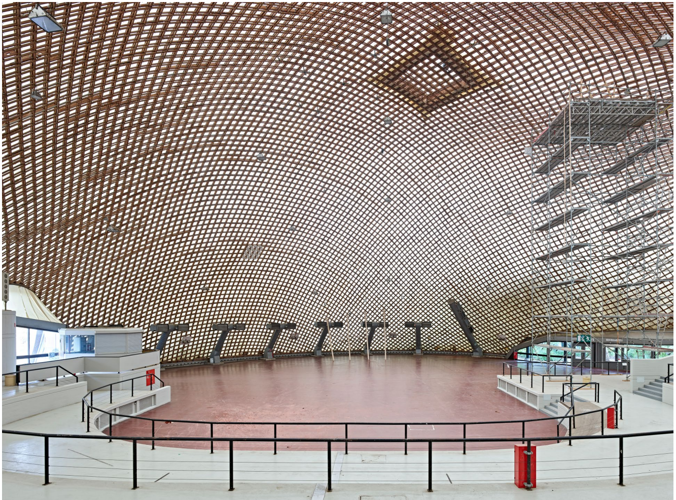
Bild 4. Innenraum der Veranstaltungshalle mit Tribünen und Gitterschale
