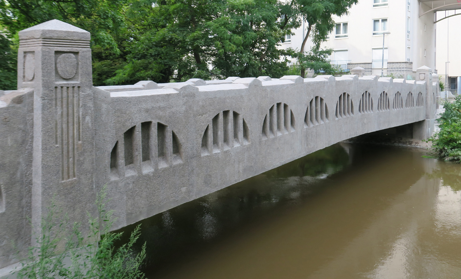
Bild 1. Brücke Dreyerstraße nach der Sanierung
