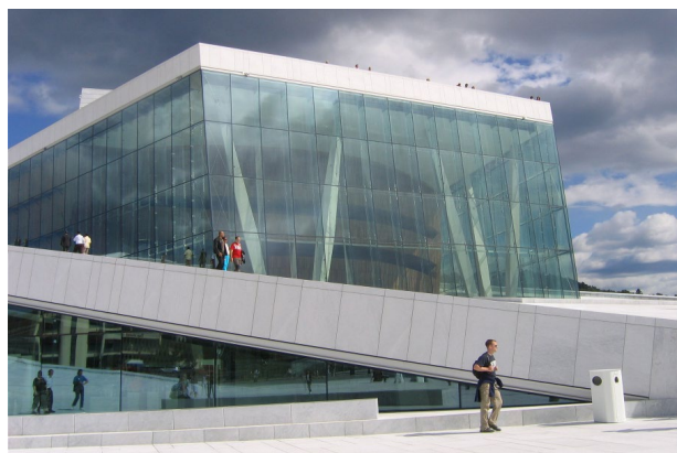
Bild 3. Schillernde Glasfassade des Foyers
