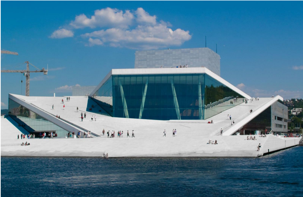
Bild 1. Das Opernhaus Oslo mit öffentlich begehbare Dachfläche
