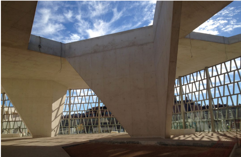
Pausenhalle: Schräg angesetzte, sich verjüngende Stützen
