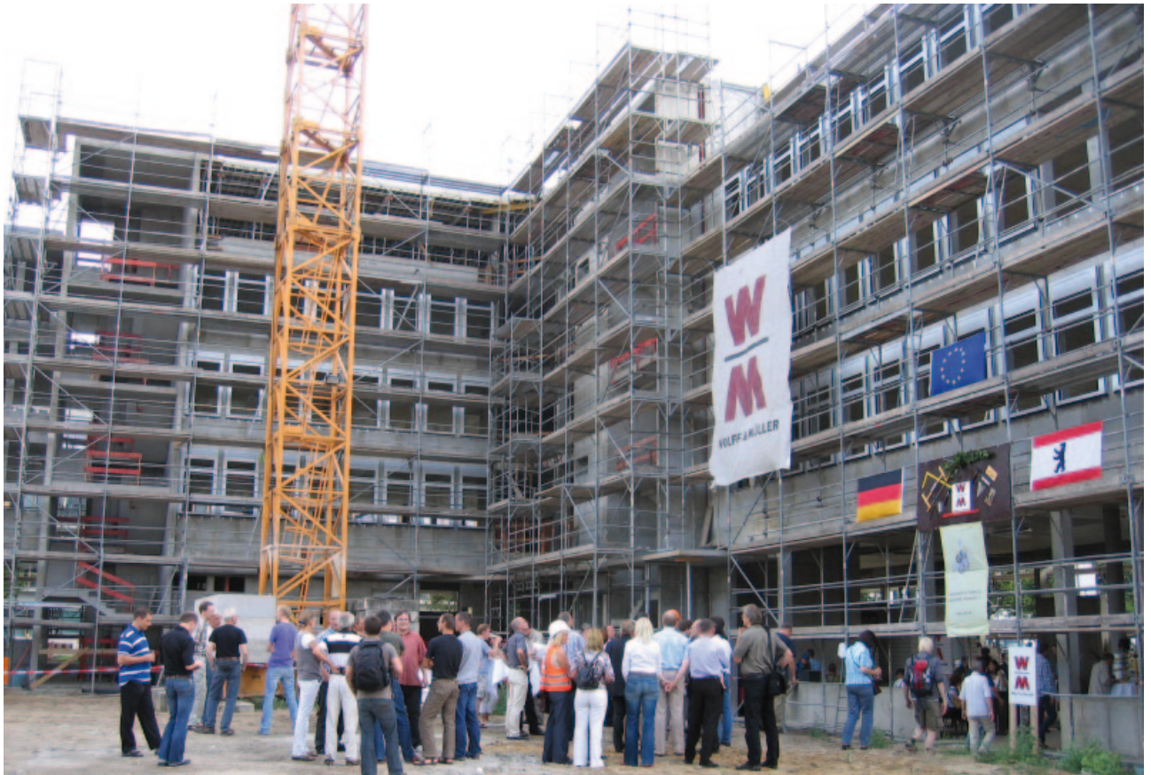
Gfal - Gesellschaft zur Förderung angewandter Informatik. Neubau eines Laborgebäudes in Berlin Adlershof
